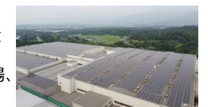
いなべ工場建屋への太陽光パネル設置状況
